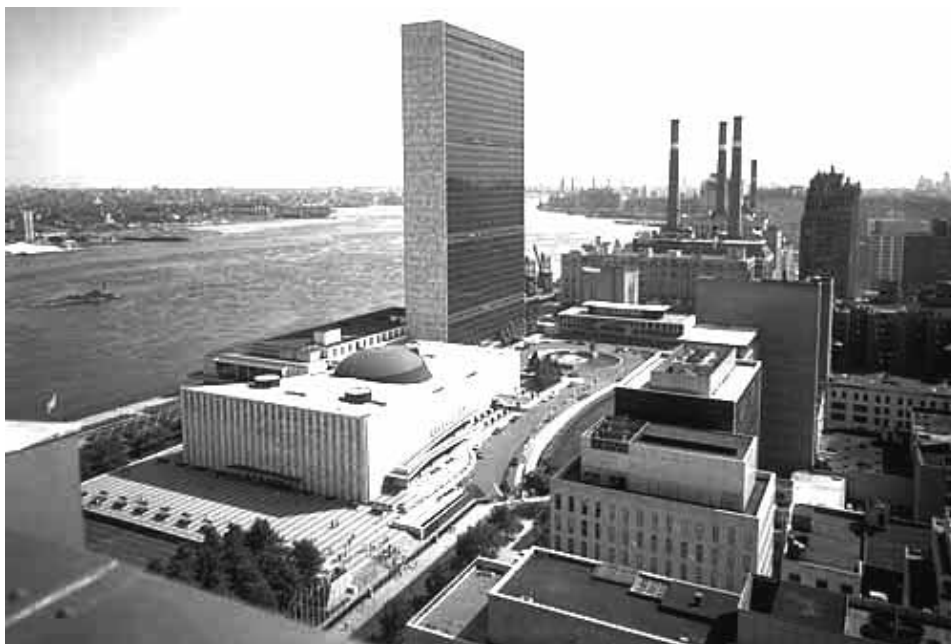
Der Gebäudekomplex der Vereinten Nationen in New York
